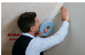
Páraszabályozó réteg illesztése tömör falszerkezethez
