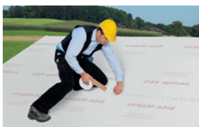
Páraszabályozó réteg felerősítése szarufa feletti szigeteléshez
