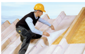
Páraszabályozó réteg felerősítése tetőfelújítás esetén, kívülről
