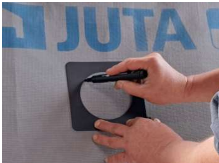
A mellékelt sablonnal rajzoljuk ki szellőző helyét
