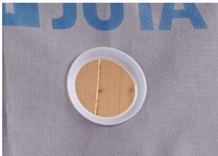
A gyűrű megakadályozza a csapadék bejutását
